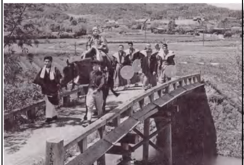
旧坂口橋（昭和 31 年）、小泉川に架かる土橋の旧坂口橋を渡る祭りの列。左奥の山が高台（当時金ヶ原）。
