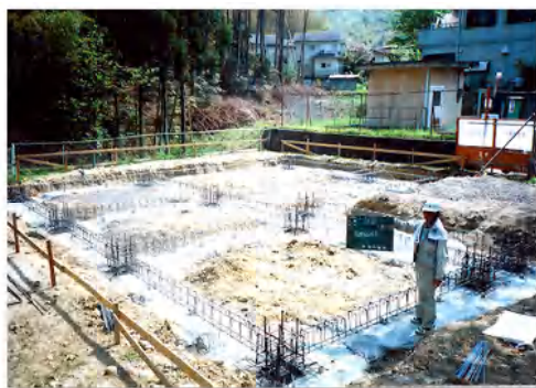
さくら会館の工事、平成 17 年
