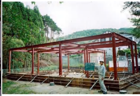
高台集会所（平成 17 年） 、建設中の高台集会所（さくら会館、床面積 32 坪）。当初 2 号公園で計画されましたが、3 号公園での建設となりました。
