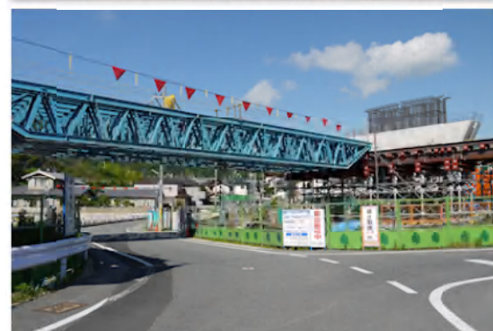
変わりゆく高台周辺、にそと工事が進む菩提寺橋付近、上：昭和45年（東を望む） 下：平成23年
