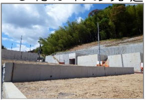
4丁目南の造成された宅地
